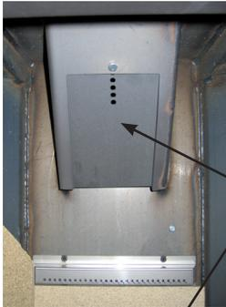
Regulierbare Leitplatte zur Steuerung der Abgasströme
