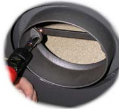
Abb. 16 Den Stützen zentrieren und Schrauben anziehen.
