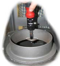
Abb. 12 Schrauben im oberen Rauchrohrstützen lösen.
