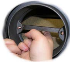
Abb. 15 Rauchrohrstützen mittels Schrauben oder Halter hinten am Ofen befestigen.
