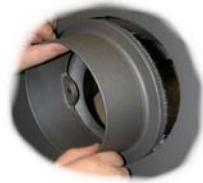
Abb. 14. Stützen durch die rückwärtige Platte an den Feuerraum setzen.
